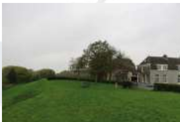
2. Batterijen bij de Dalemse sluis
